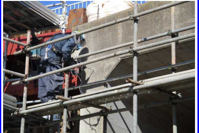
墨出し、アンカーボルト打設
