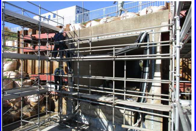
伸縮ゴム取付け
