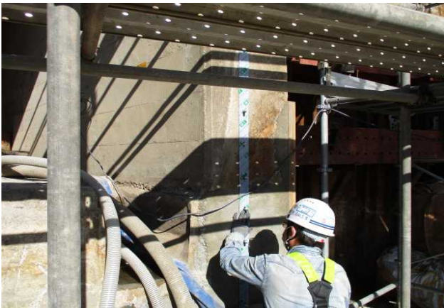
ボンド(PB-50)塗布、スパンシール(シール材)貼付け
