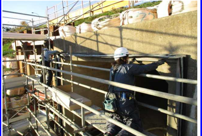
クッション材取付け、仕上げ
