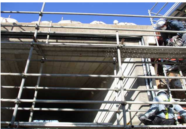
押え板取付け、トルク確認
