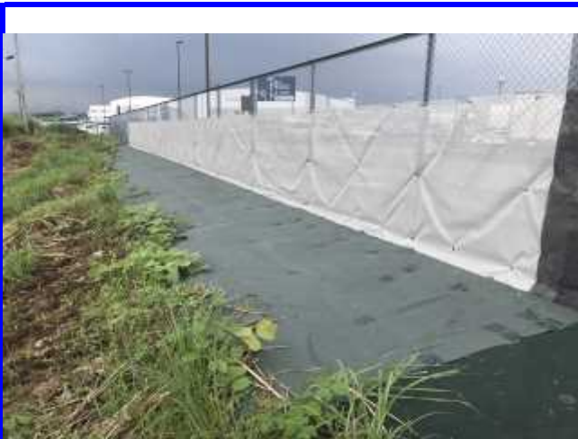
静岡空港 試験施工
