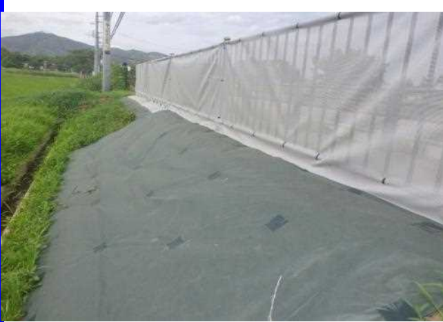
茨城県土浦土木事務所 試験施工
