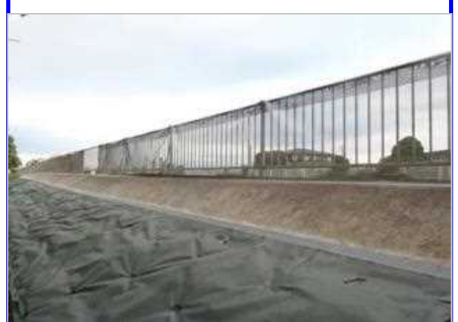
栃木県宇都宮国道事務所矢板出張所 試験施工
