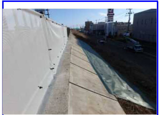
仙台河川国道事務所仙台東維持出張所 試験施工
