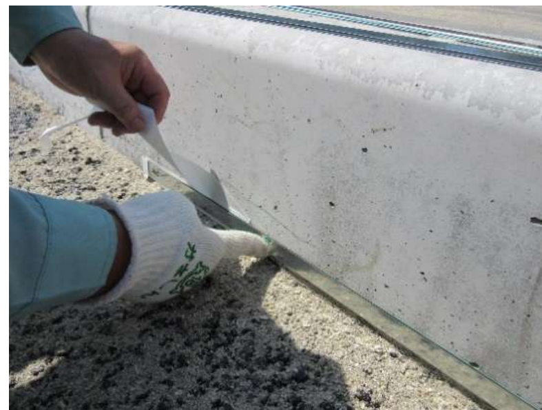
施工面清掃後、製品の貼り付け
