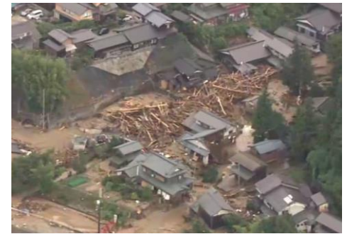
土石流等による被害 (新潟県村上市)
