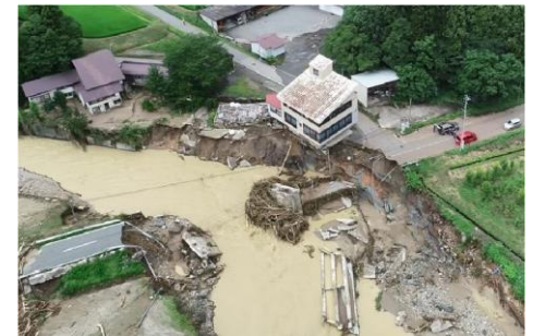
主要地方道長井飯豊線 橋梁崩壊 (山形県飯豊町)
