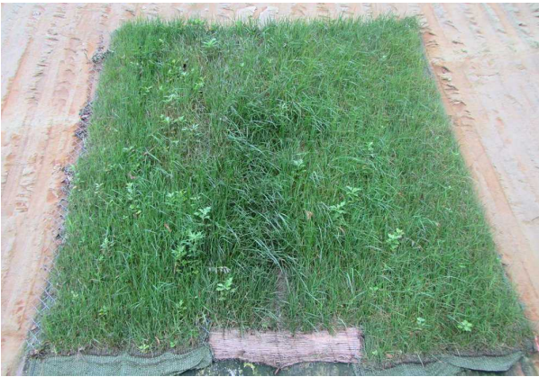
強酸性pH=3.0での施工事例
