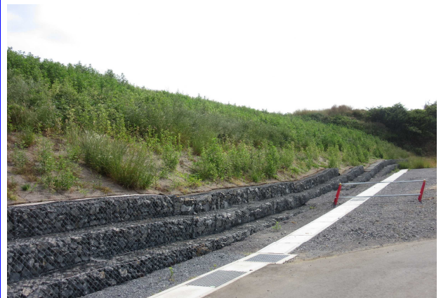
フルボキャッチャーIV(無種子) 施工後4ヶ月経過
