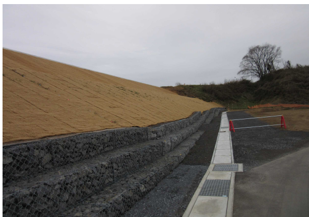
フルボキャッチャーIV(無種子) 施工直後
