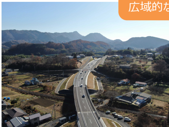
国道118号袋田バイパス
