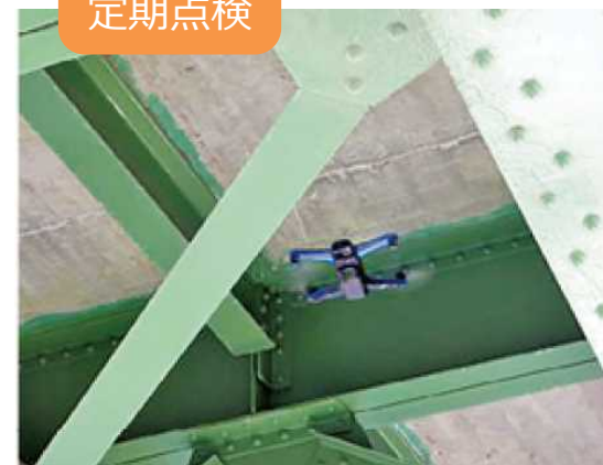
ドローンによる橋梁点検
