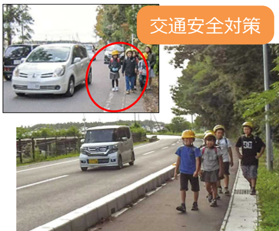
通学路の歩道整備
