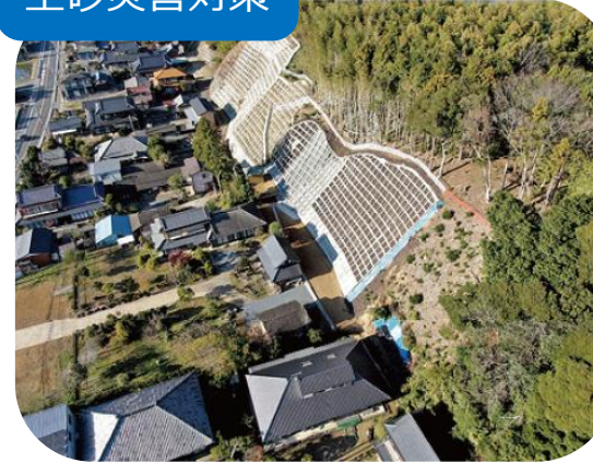
急傾斜地崩壊対策（弁才天2）
