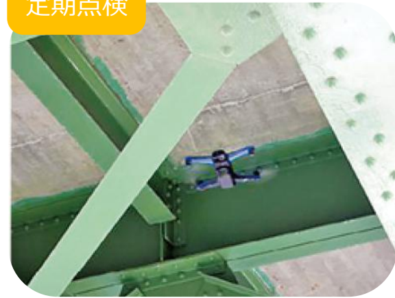
ドローンによる橋梁点検
