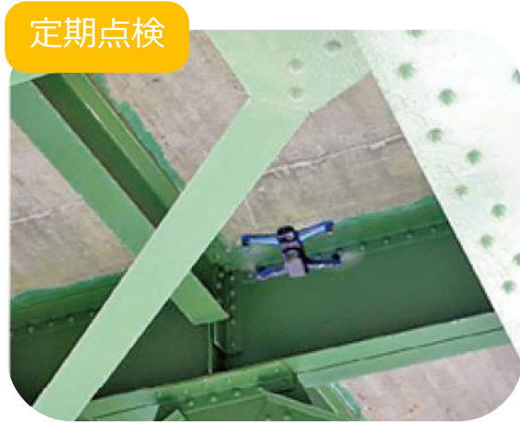
ドローンによる橋梁点検
