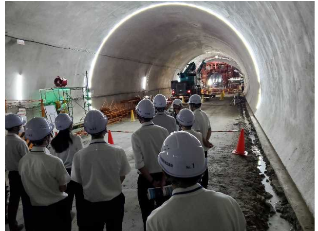
写真2 （仮称）上曽トンネル工事見学
