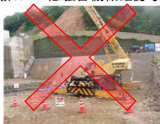
排ガス・低騒音機械確認写真
