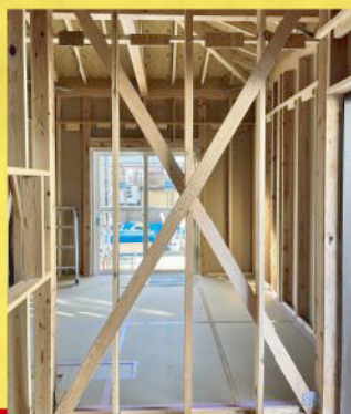
事例① 筋交いによる補強
