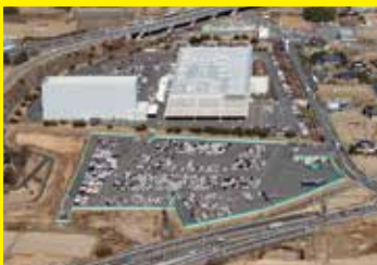
輸入車の新車整備センター
