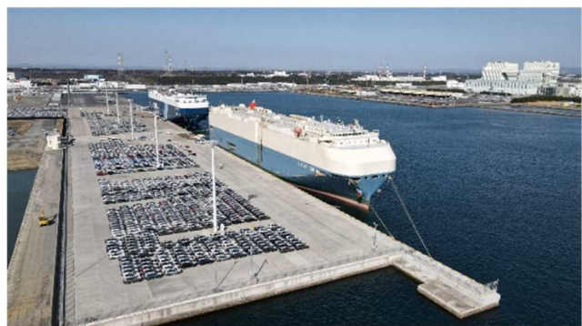
中央D岸壁(R5.3 月供用開始)
