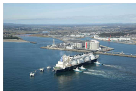
日立 LNG 基地
