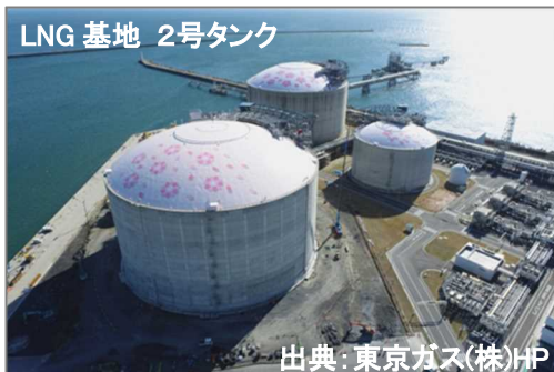
【日立LNG基地全体概要】
