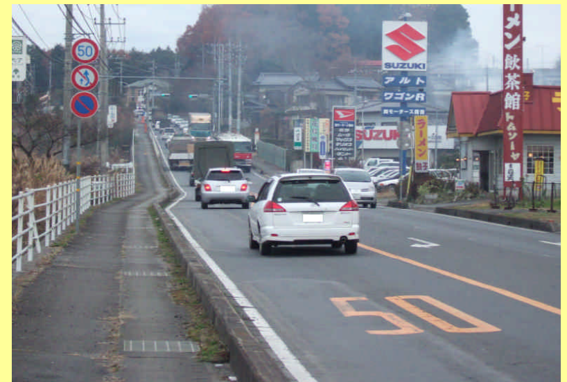
工事前の状況
