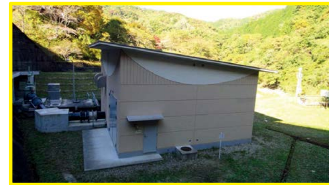
管理用発電所 外観
