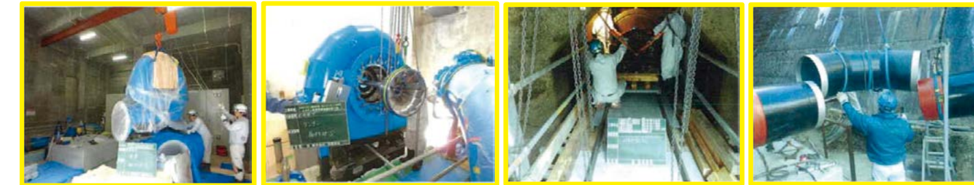
施工中の様子(左から、水車搬入、ランナ取付、利水放流バルブ移設、水圧鉄管取付)
