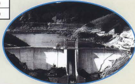
ダム建設当時の写真
