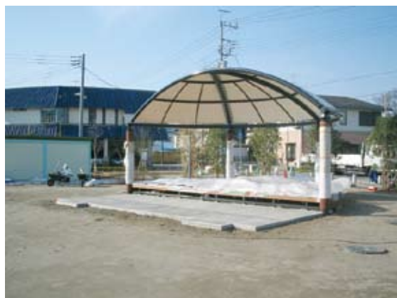
中心市街地に多くの人々を集めるための拠点づくりとして期待の寄せられている「にぎわい広場」。平成22年3月に完成予定
