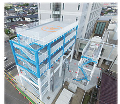
水害避難タワー
