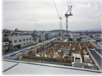
新病院（建設中）
