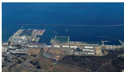
<大水深岸壁など機能強化が進む常陸那珂港区>
