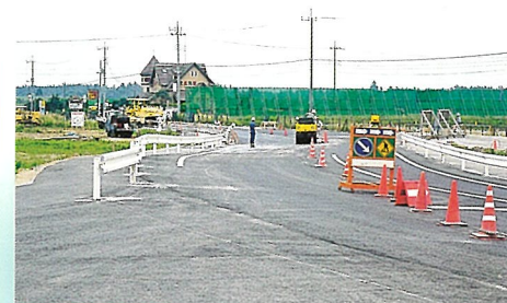
④街路築造工事：谷和原村西樋戸地内 (都計道3号線迂回路工事)
