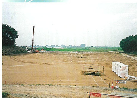
③地盤改良工事：谷和原村西樋戸地内 (ペーパードレーン工法による地盤改良)
