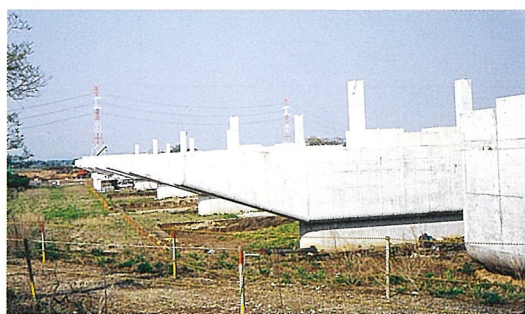
①小貝川橋りょう:谷和原村筒戸地内 (谷和原村側より伊奈町側を望む)
