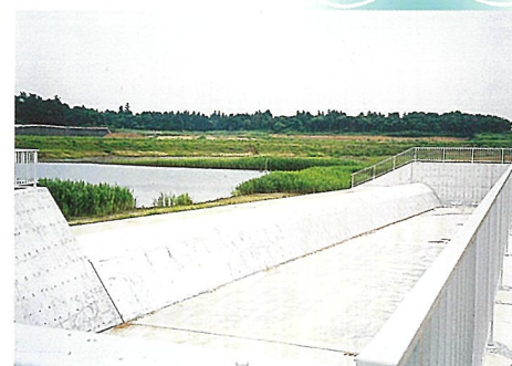
②第2調節池工事：谷和原村真木地内 (洪水吐より地区内を望む)
