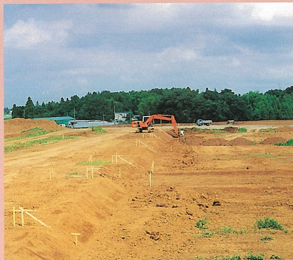
①一次造成工事中
