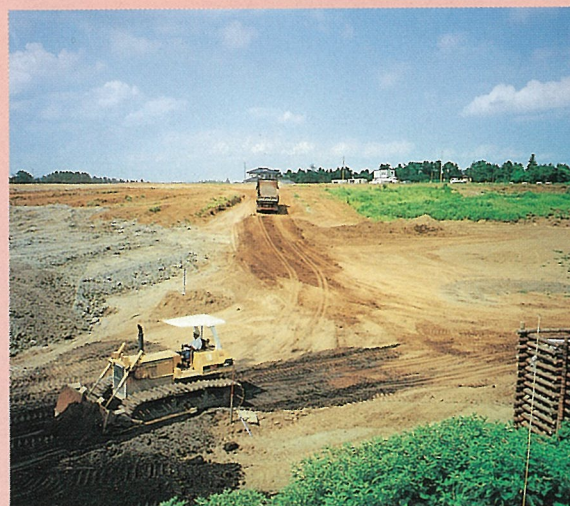
③一次造成工事中
