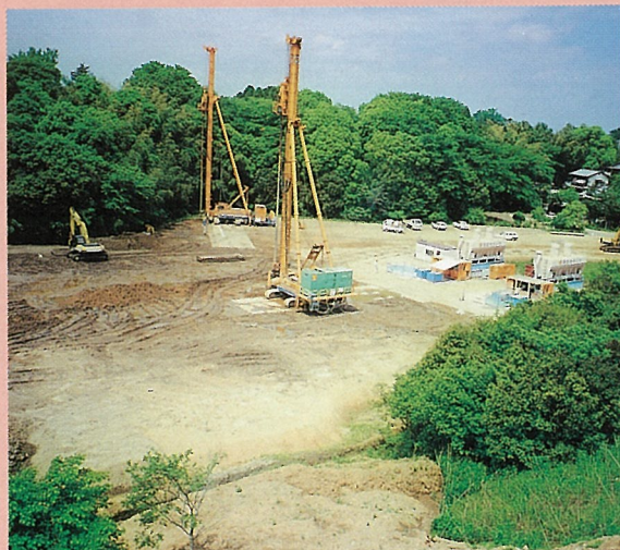
②第3調節池築造工事中
