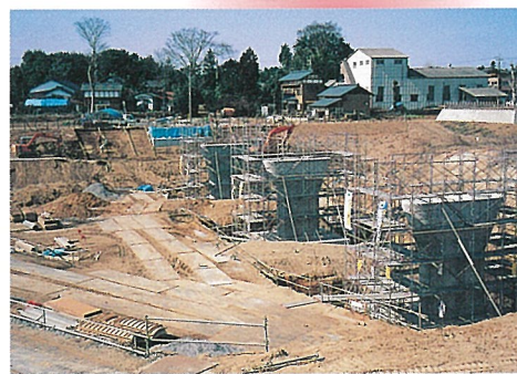
第3調節池を跨ぐ橋梁下部工事:橋台2基、 橋脚3基を施工中 (谷和原村東樋戸付近)
