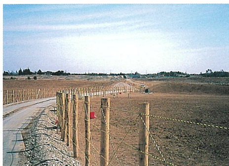
一次造成工事の状況 (谷和原村東樋戸付近)
