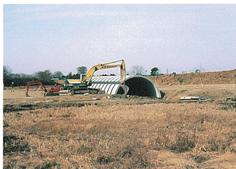
※モジュラーチ工法による都計道5号線 BOX工事 (谷和原村田付近)
