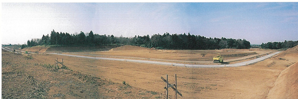
都計道6号線付近の造成工事の状況 (谷和原村田付近)
