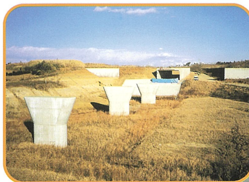
第3調節池を跨ぐ橋梁下部工事
