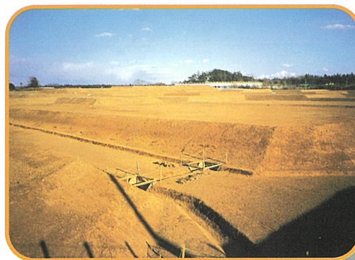
一次造成工事の状況
