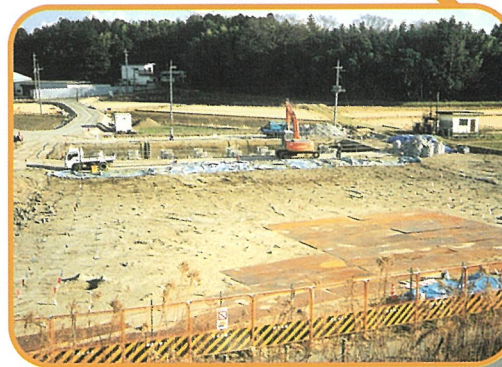
都計道2号線の橋梁（橋台）工事
