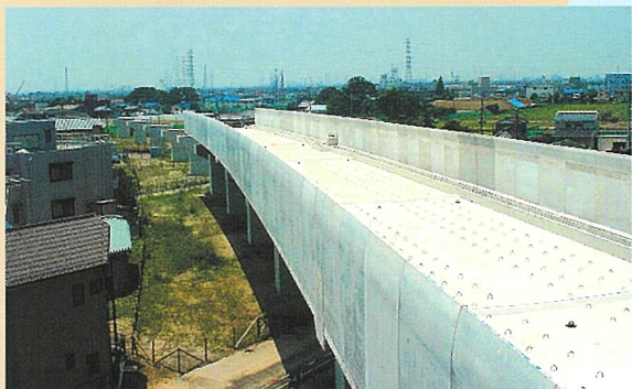
江戸川西高架橋
