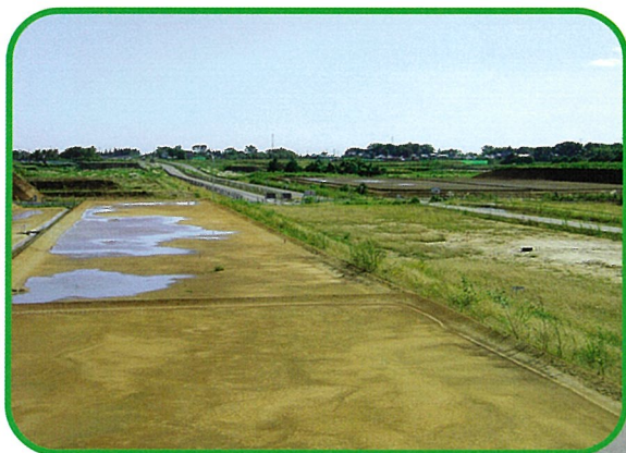
都計道1号線付近の造成工事の状況
