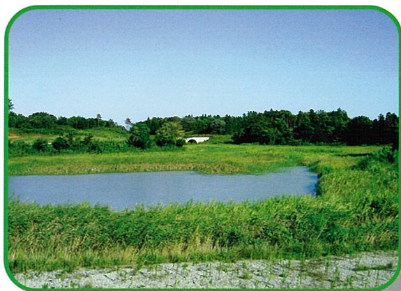
第1調節池（調節池下流側から上流側を望む）
