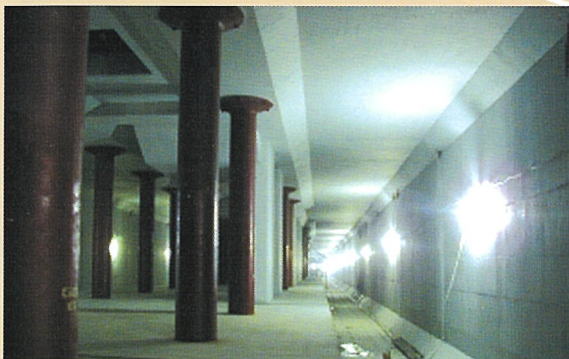
元浅草駅/軌道階(地下駅)
