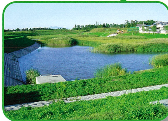
第4調整池（調整池下流側から上流側を望む）
