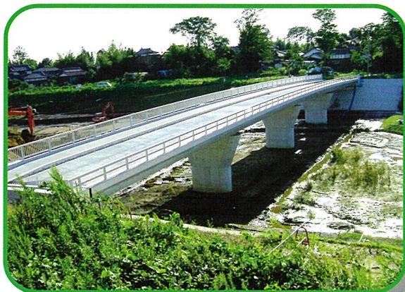
第3調節池を跨ぐ橋梁
