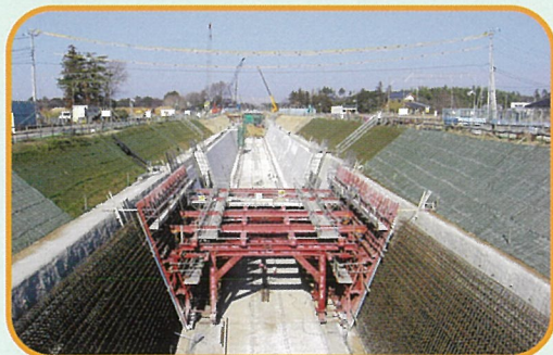
鉄道工事の様子
