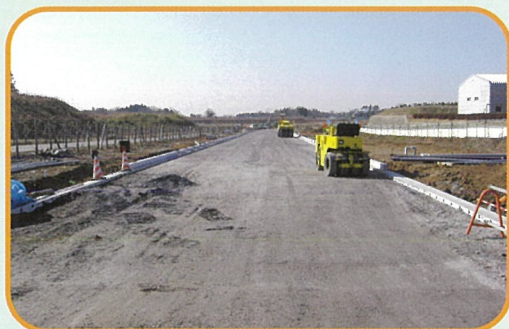
都計道7号線工事の様子
