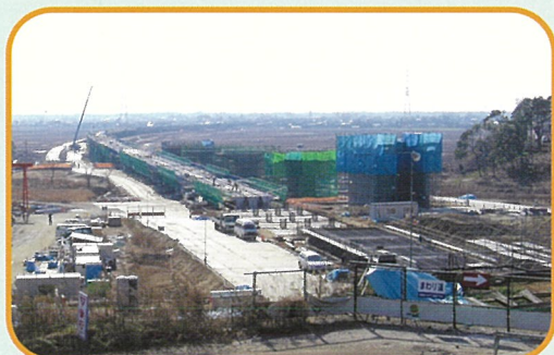
鉄道・都計道1号線の橋脚工事の様子
