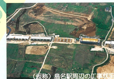
（仮称）島名駅周辺の工事状況
