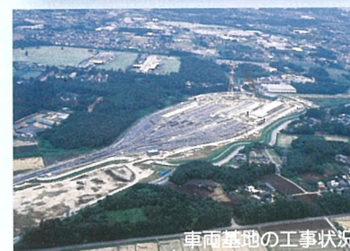
車両基地の工事状況
