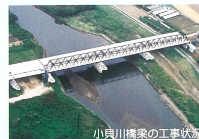
小川橋梁の工事状況
