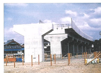
【江戸川西高架橋・埼玉県】
