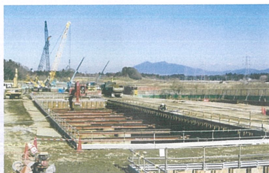
(仮称)島名駅基礎工事の状況
