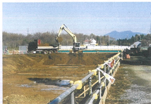
路盤工事の状況
