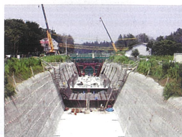
路盤工事状況
