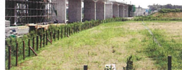
高架工事状況
