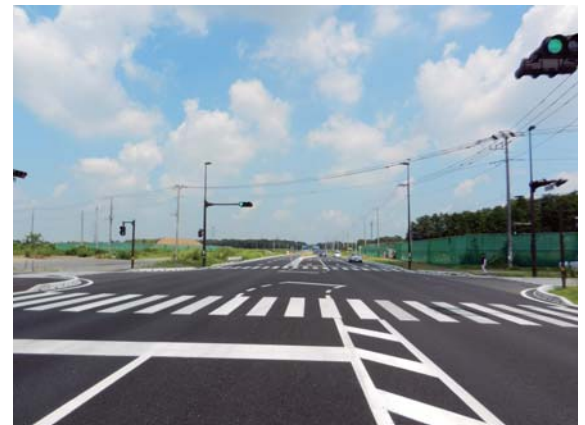
② 工事が完了した県道つくば真岡線バイパス交差点の様子
