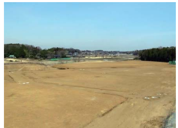
③ 県道島名上河原崎線北側の造成工事の様子
