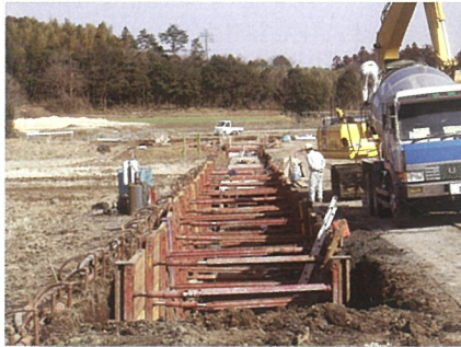
⑤雨水管整備
