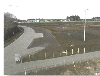
③早期建設街区（北側）
