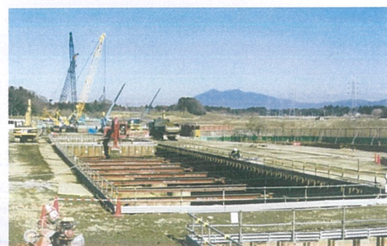
(仮称)島名駅基礎工事の状況
