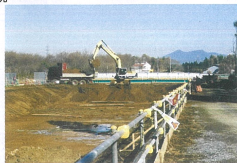
【いずれも2002年1月撮影】 路盤工事の状況
