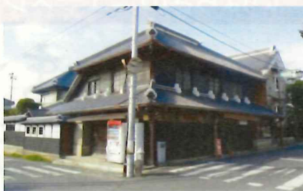
▲重要伝統的建造物群保存地区にある潮田家
