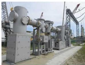
ガス絶縁開閉装置 (変更後)
