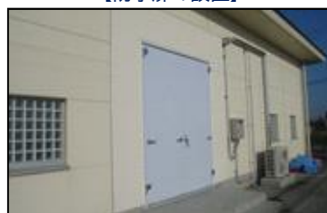
【防水扉の設置】
