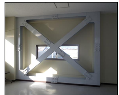
【建築物の耐震補強】
