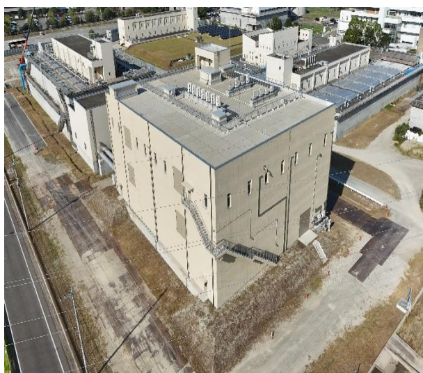
オゾン促進酸化処理施設
