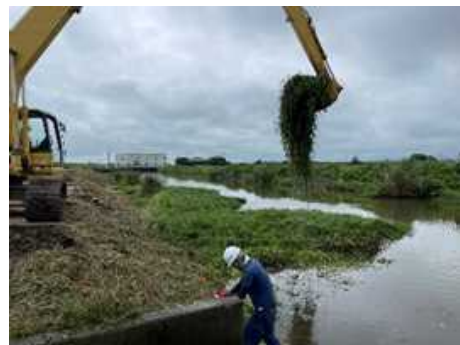
水路における駆除作業
