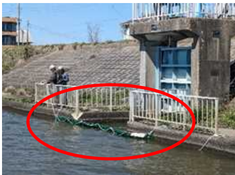
進入防止フェンスの設置状況
