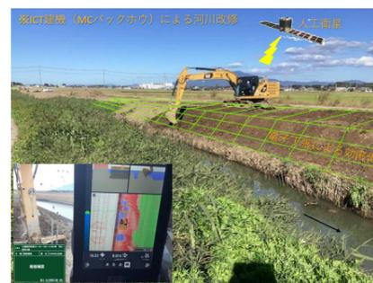
写真1 3次元設計データによる施工
