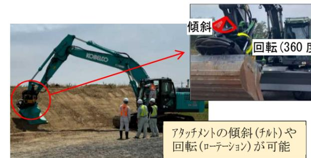
写真4 ICT施工の高度化
