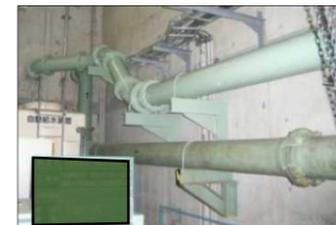
写真4 圧送管の2条化
