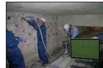
写真3 処理場の耐震補強状況
