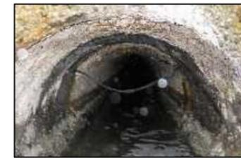
写真1 腐食進行後の管路の状況
