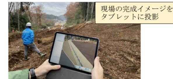
写真6 アプリ (AR) を用いた現場作業の効率化
