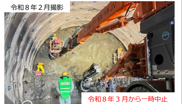
IV (仮称) 大久保町第2トンネル 掘削工
