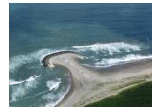
【ヘッドランド設置状況（鉾田市）】
