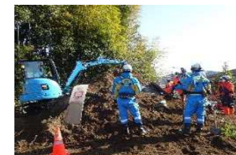
バックホウを活用した土砂排除
