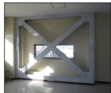
【建築物の耐震補強】
