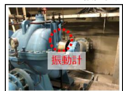
ポンプへのセンサ設置状況
