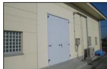
【防水扉の設置】
