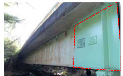
【写真 4】部分塗装の実施例
