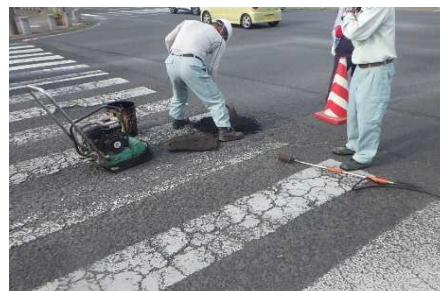
【写真 2】路面補修の状況
