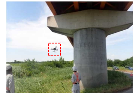
【写真 3】ドローンを活用した橋梁点検
