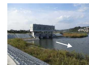
【写真 8】樋門の遠隔化 (落見川樋門)
