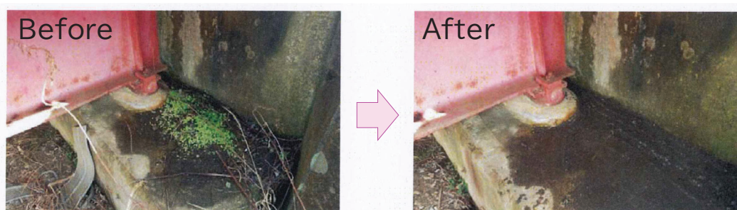
(城里町・町道パトロール時の土砂払い例, 2015.2)
