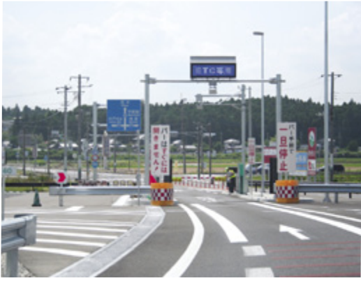
水戸北スマートインターチェンジ
