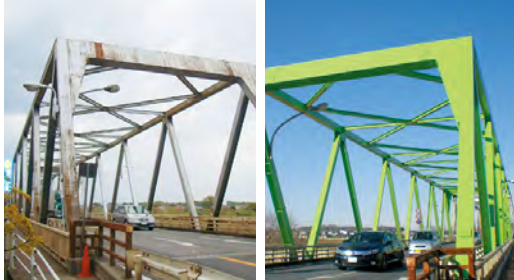
道路施設の適切な維持管理を推進 (左)対策前(右)対策後
