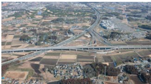
多大な整備効果を有する圏央道(つくば市内、国土交通省提供)
