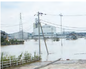
関東・東北豪雨で浸水被害を受けたカントリーエレベーター(常総市)
