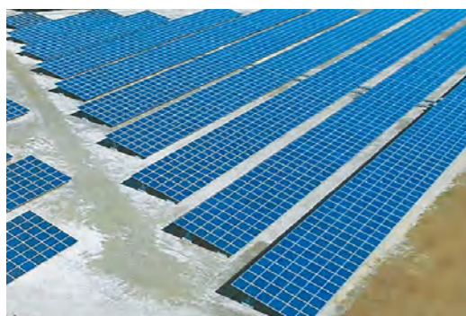
設置が進む太陽光発電施設
