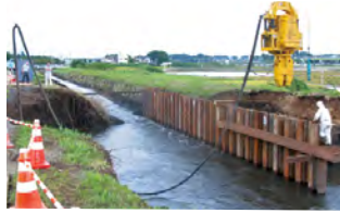
宮戸川(古河市)における応急復旧工事の状況
