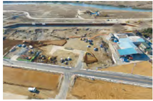
鬼怒川堤防の本復旧状況
