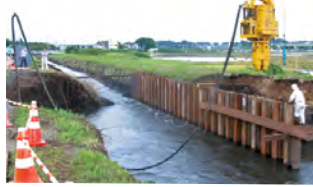
宮戸川(古河市)における応急復旧工事の状況
